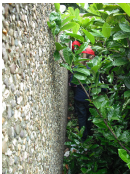
😊 Mülltonnenhäuschen vor Witzlebenstraße 22 eignen sich zum Verstecken, Ticken spielen und haben einen Geheimgang dahinter (10)
