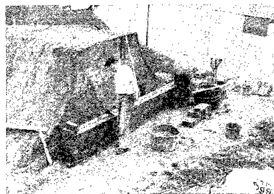
Für die Formgebung mit der Schaufel war das Stahlkorsett bis zu einer Tiefe von 1,80m ein hervorragender »Leitfaden«.
