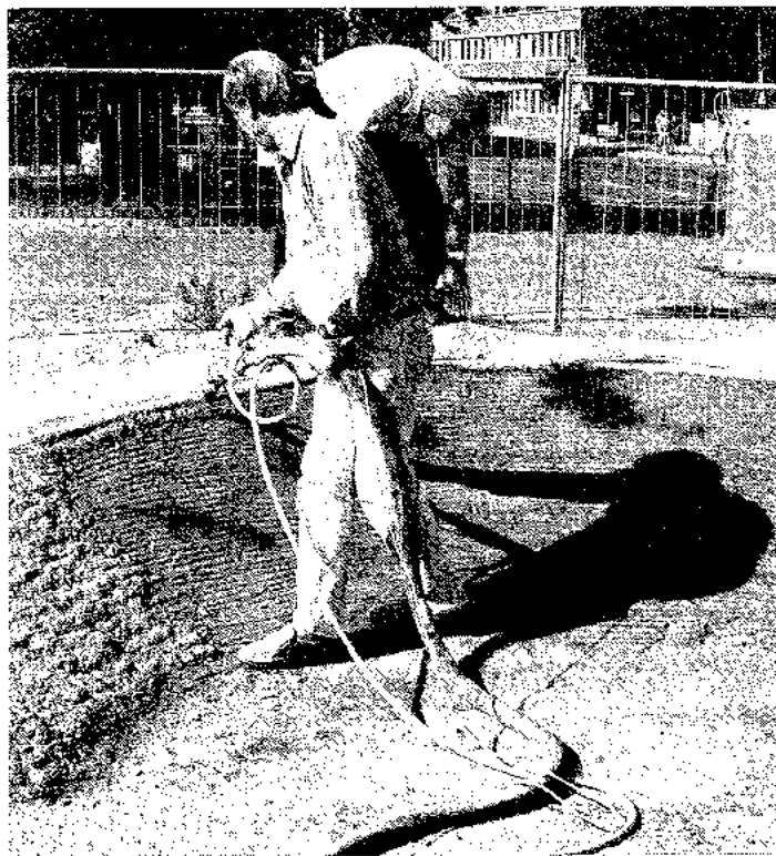
Hier wird am Babypool die letzte Deckschicht aufgetragen.
