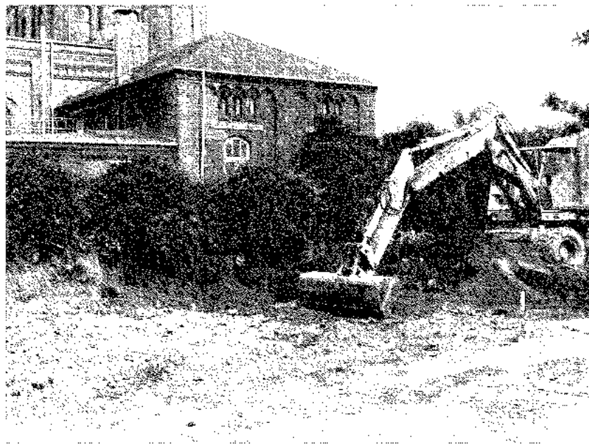
Der Schaufelbagger ebnet das Gelände für die Pool-Anlage.
