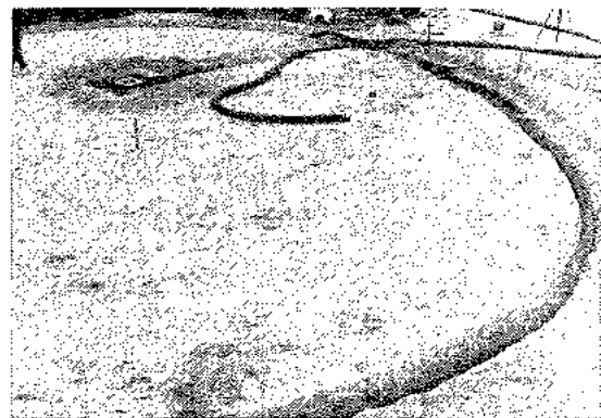
Zu den ersten Arbeiten gehört das Verlegen der Drainage, in die das Oberflächenwasser versickert.
